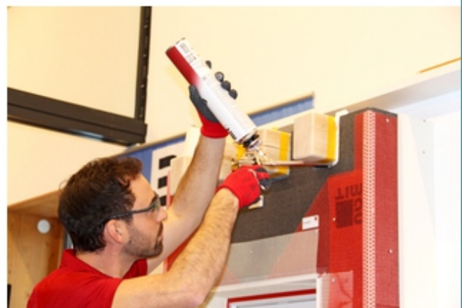
Der „Elastik-Schaum“ ist ein Polyurethan-Schaum für Abdichtungen und wird an Bauteilübergängen beim WDVS aufgesprüht, wie Anwendungstechniker Roberto Fallico zeigte Foto: Michaela Podschun
