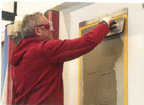
Anwendungstechniker Willi Weng brachte den Haftmörtel „HM 50“ auf, der sich als Dünnschichtputz eignet
