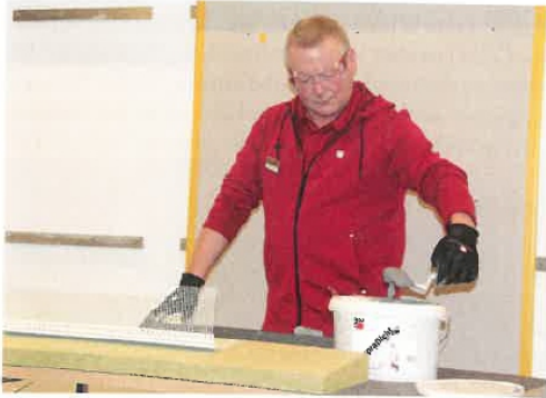
Anwendungstechniker Andreas Endter strich die Abdichtung „Supradicht“ für die Herstellung einer zweiten Dichtungsebene unter der Fensterbank auf den Dämmkeil
