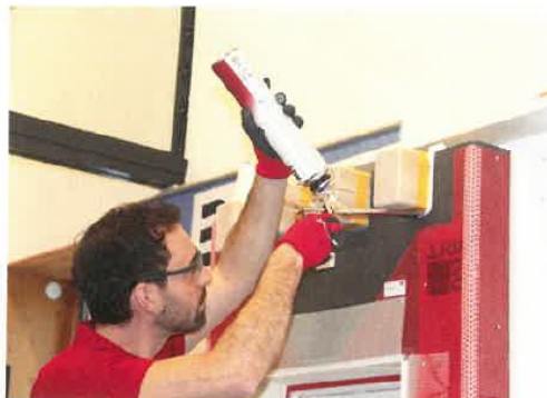
Der „Elastik-Schaum“ ist ein Polyurethan-Schaum für Abdichtungen und wird an Bauteilübergängen beim WDVS aufgespritzt, wie Anwendungstechniker Roberto Fallico zeigte
